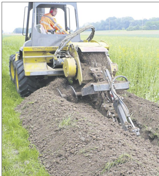
Die Grabenfräse kommt vor Verlegen der Kabel zum Einsatz und soll die Umwelt schonen. Bild: ENBW
